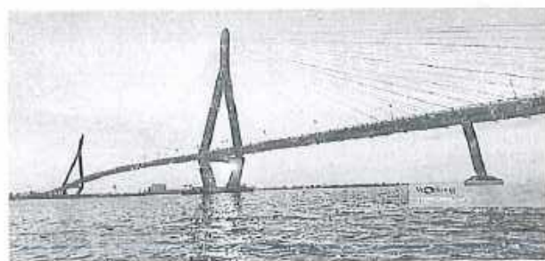
Hình ảnh 3: Cầu Cần Thơ Gối thầu P1 - Cầu dẫn phía Vĩnh Long thuộc dự án cầu Cần Thơ (2005 - 2009)
